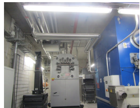
Holzsnitzel-Heizkessel / Elektrofilter
