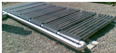
Vakuumröhrenkollektoren
