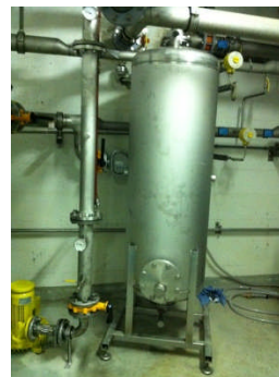
Gasdruckerhöhungsgebläse / Siloxanfilter
